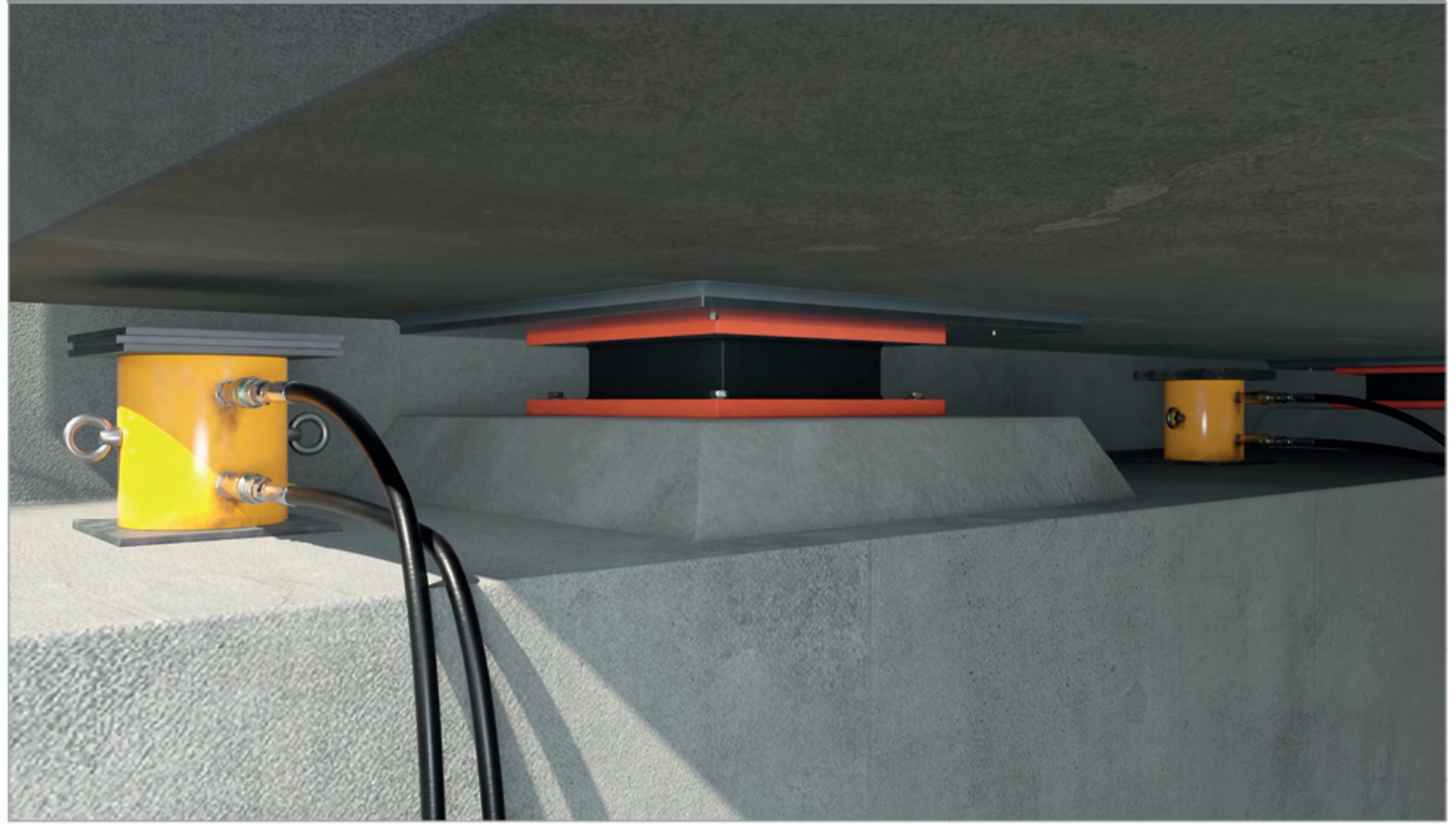
STEP 2 _ 유압잭 설치
