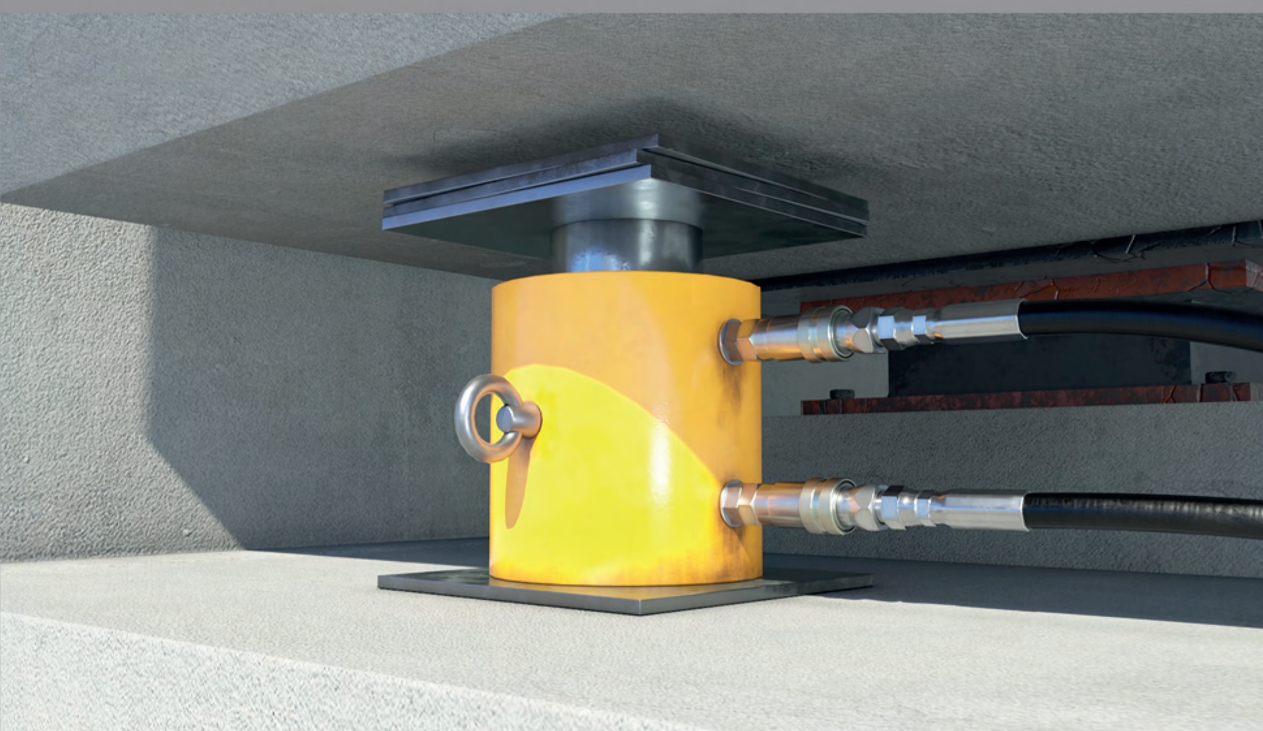
STEP 5 _ 유압잭 상판지지대 설치
